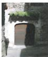
Ouverture : Linteau en "anse de panier"
