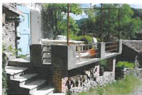
Luziers - Eviter la construction de terrasses dans des matériaux en opposition avec ceux de la construction (ici, béton et briques)
