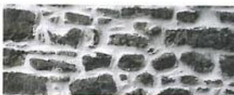
Le jointoyage des pierres devrait se faire à l'aide de ciment non teinté et correctement dosé pour qu'il ne soit pas trop clair.
