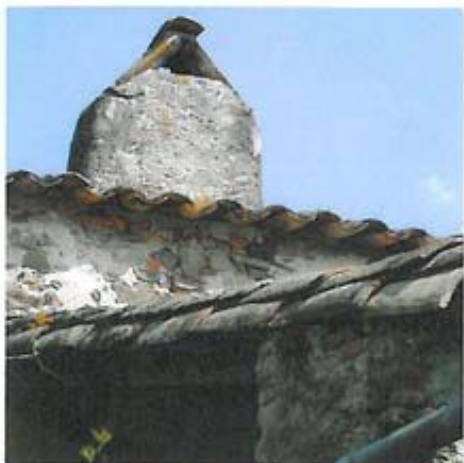
Mas Soubeyran : souches et conduits
