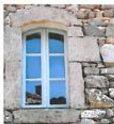
Linteau cintré en pierre Fenêtre à deux vantaux "ouvrant à la française" en bois peint et "peut bois"
