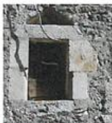
Linteau droit et arc de décharge
