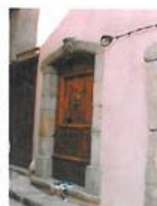
Linteau cintré en pierre avec clé de voûte décorée
