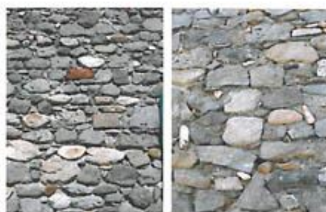
Des parements à joints secs
