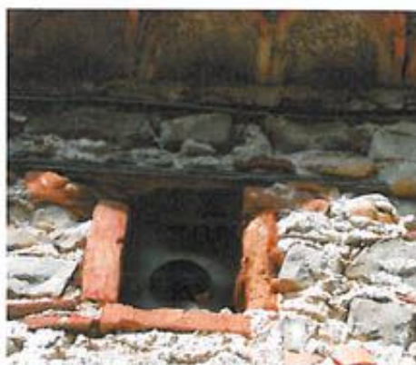
Fenestron avec encadrement en brique
