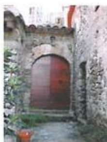
Linteau en arc tendu en pierre taillée
