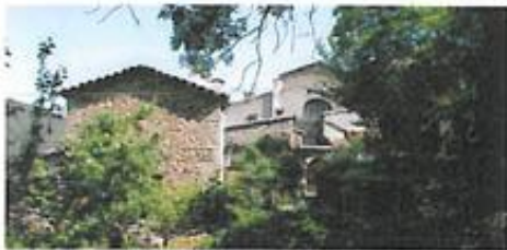
Direction des pignons
