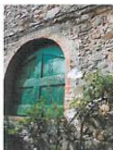
Linteau cintré en brique
