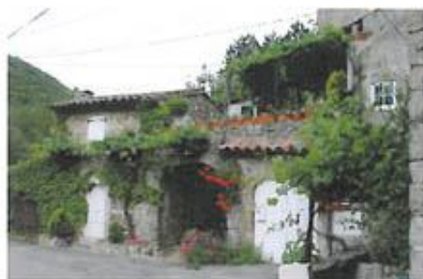
Luziers - Protection en console bois et tuiles
