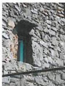
Protection de linteau en pierre
