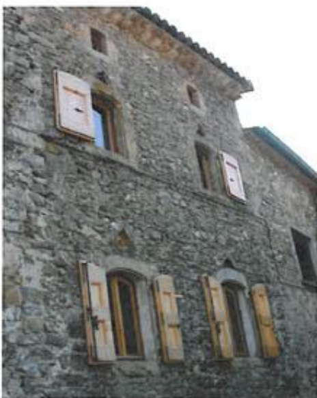
L'ordonnement contribue à l'harmonie des façades
