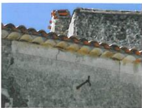
Les badigeons à la chaux soulignent chaîne d'angle, débord de couverture, encadrements de baies.
