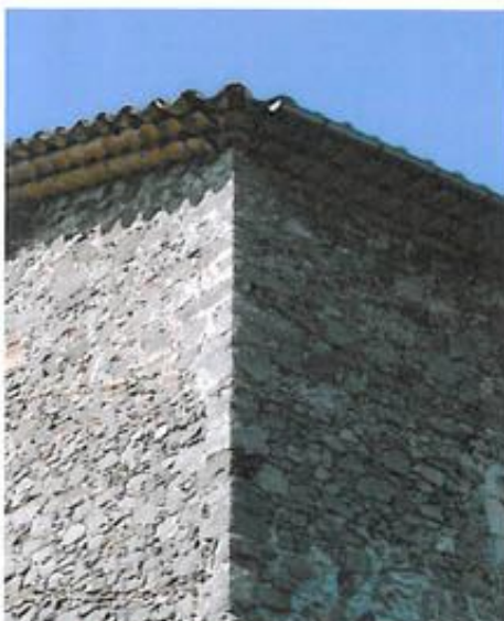
Mas Soubeyran, Débord de toiture
